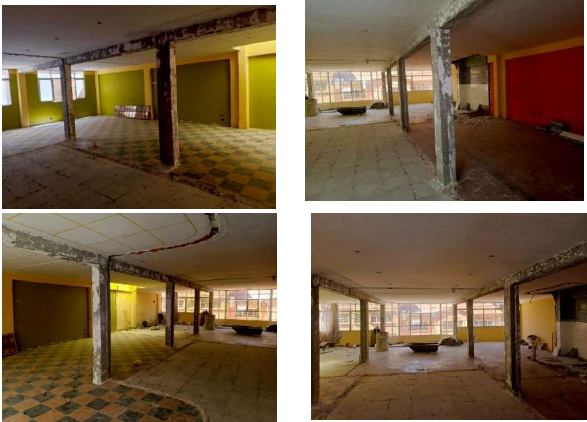
Figura 11. Proceso constructivo de columnas, vigas y losas
